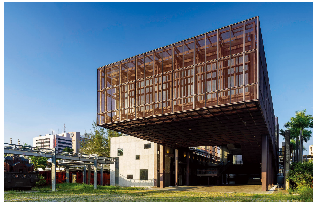
R04 館以懸空在高空約 8 公尺處，或稱為漂浮狀的量體，留出一樓廣場讓民眾自由穿越。
